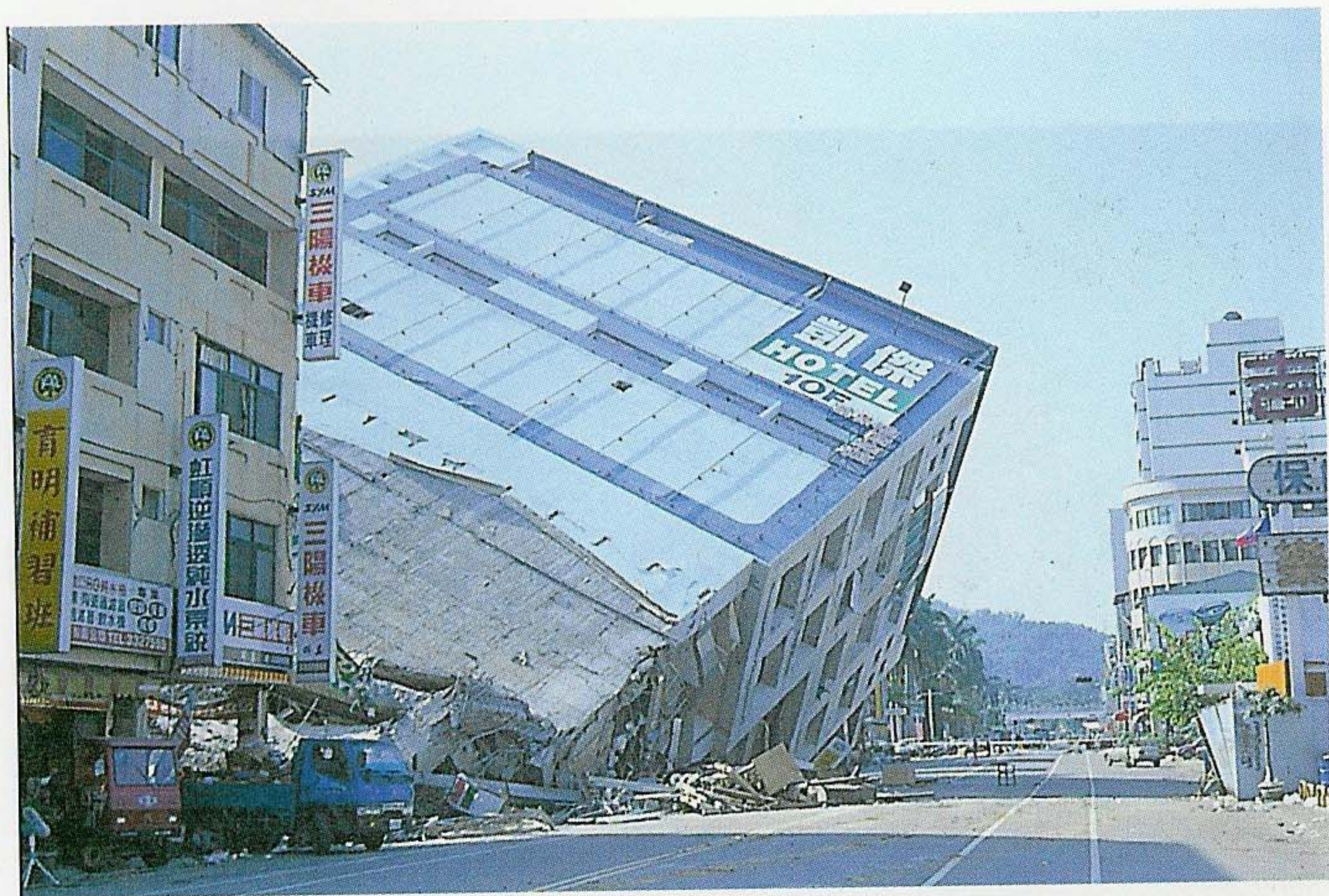
◀ 圖17 霧峰：因建築物的結構不良，造成一側的樑柱破壞而傾倒。
