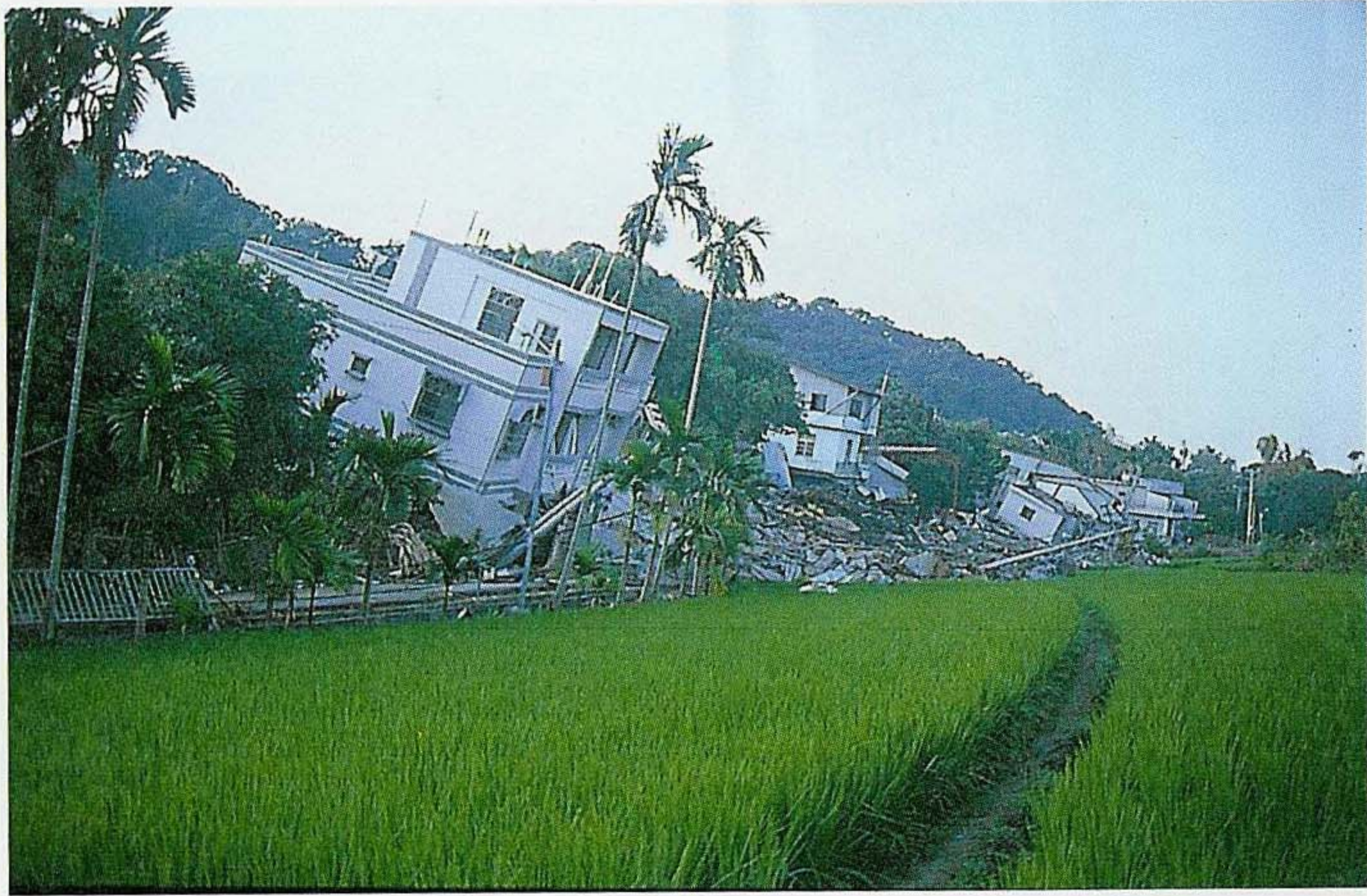
◀ 圖25 豐原（聯合新村）：斷層沿著稻田左（東）側通過，將山側的地塊隆起，造成沿著斷層線之上的房屋傾倒。
