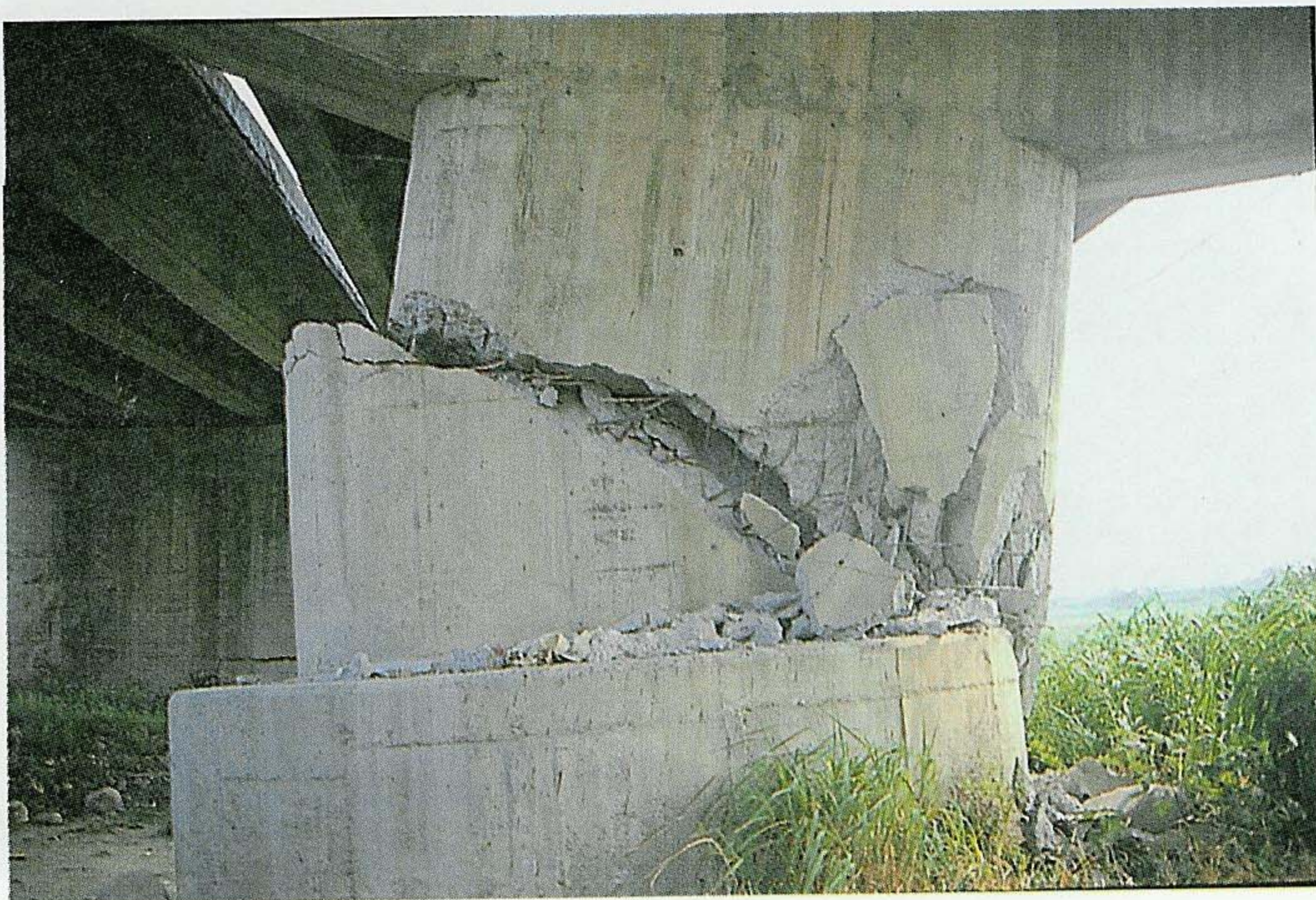
► 圖10 烏溪橋：直徑約2-3公尺的橋墩被攔腰截斷，斷層所經之處是無堅不摧，由此也可以想像大自然的力量是令人敬畏與不可輕忽。
