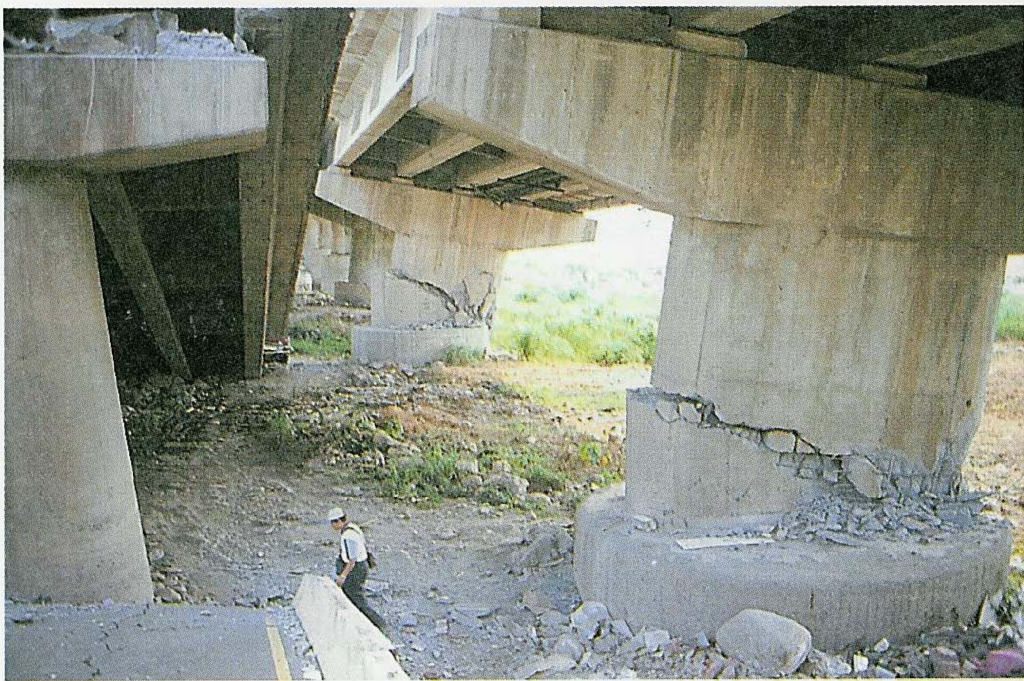
◀ 圖9 烏溪橋：車籠埔斷層經過霧峰連接草屯的要道，烏溪橋的北側第四與第三個橋墩之間。
