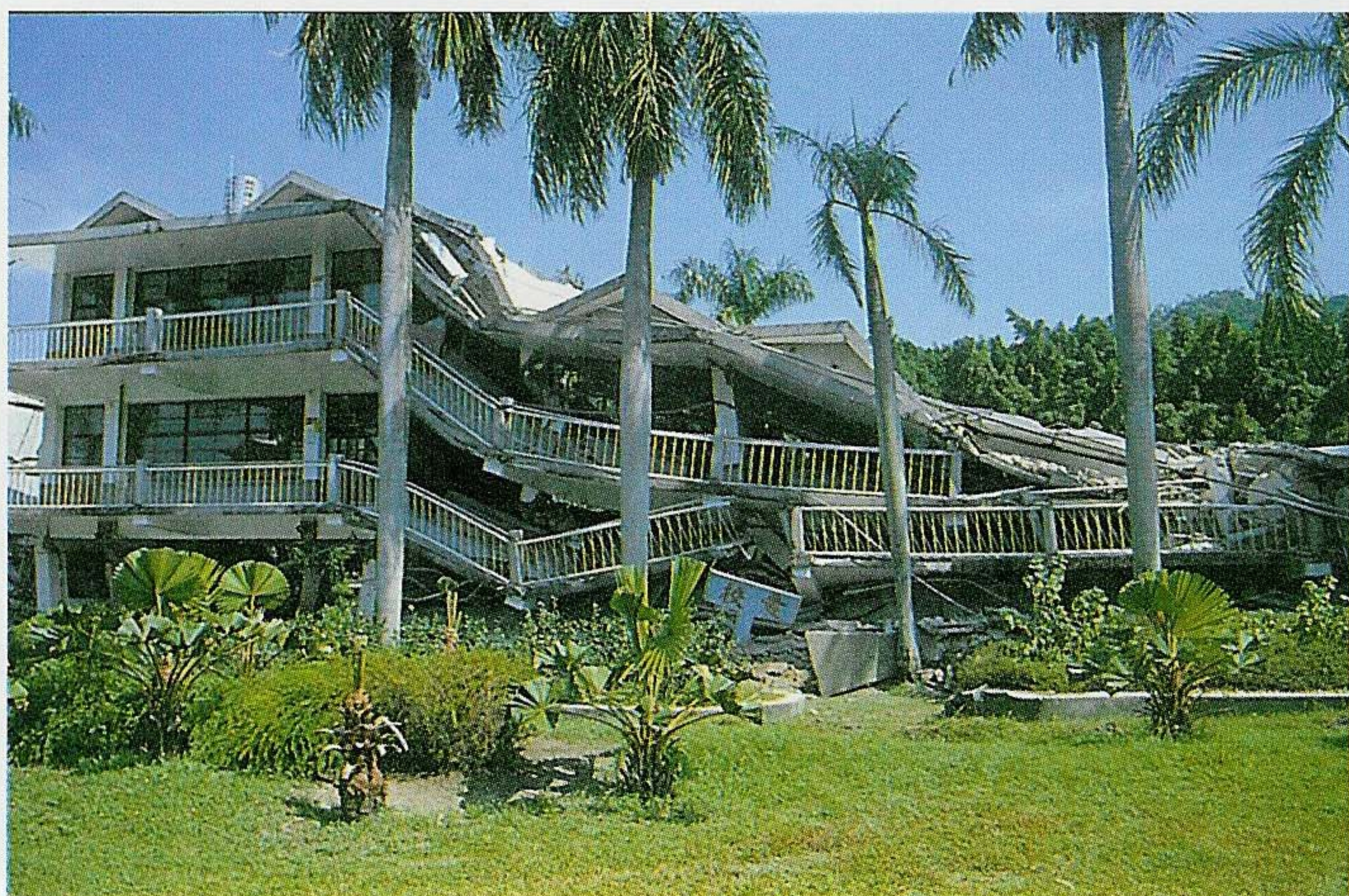
◀ 圖15 霧峰光復國小：921集集大地震當中造成許多的校舍的破壞與傾倒，慶幸地震發生在夜晚，教室中沒有學生與教師。
