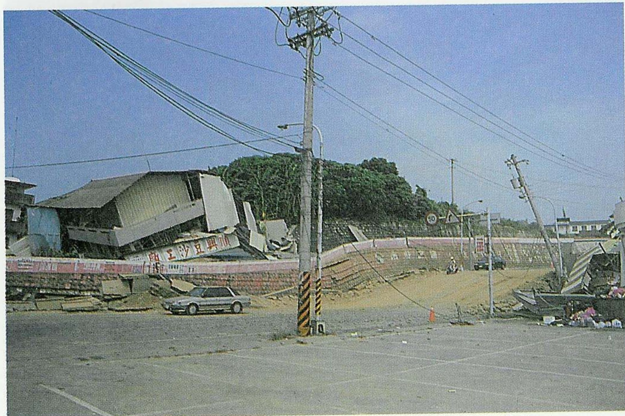
◀ 圖11 烏溪萬豐：斷層將原來是水平的圍牆抬起，形成兩段的圍牆。斷層經過圍牆內房屋的一側，也將房屋抬高造成傾斜。
