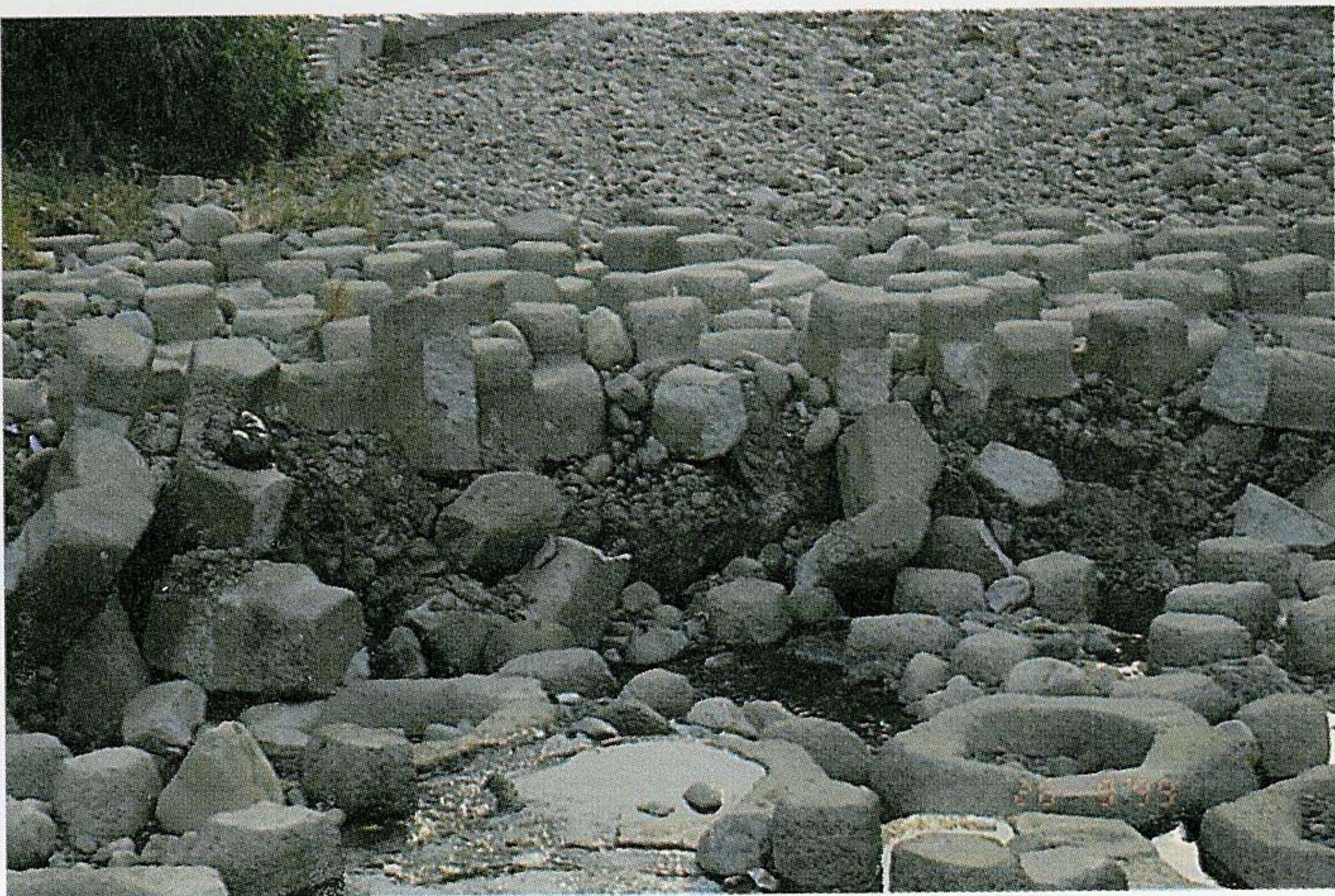
▶ 圖20 竹仔坑(建民橋)：地震斷層通過平鋪在河床上的消波塊，將照片中左側的河床抬高約1公尺，並且將消波塊剪斷。
