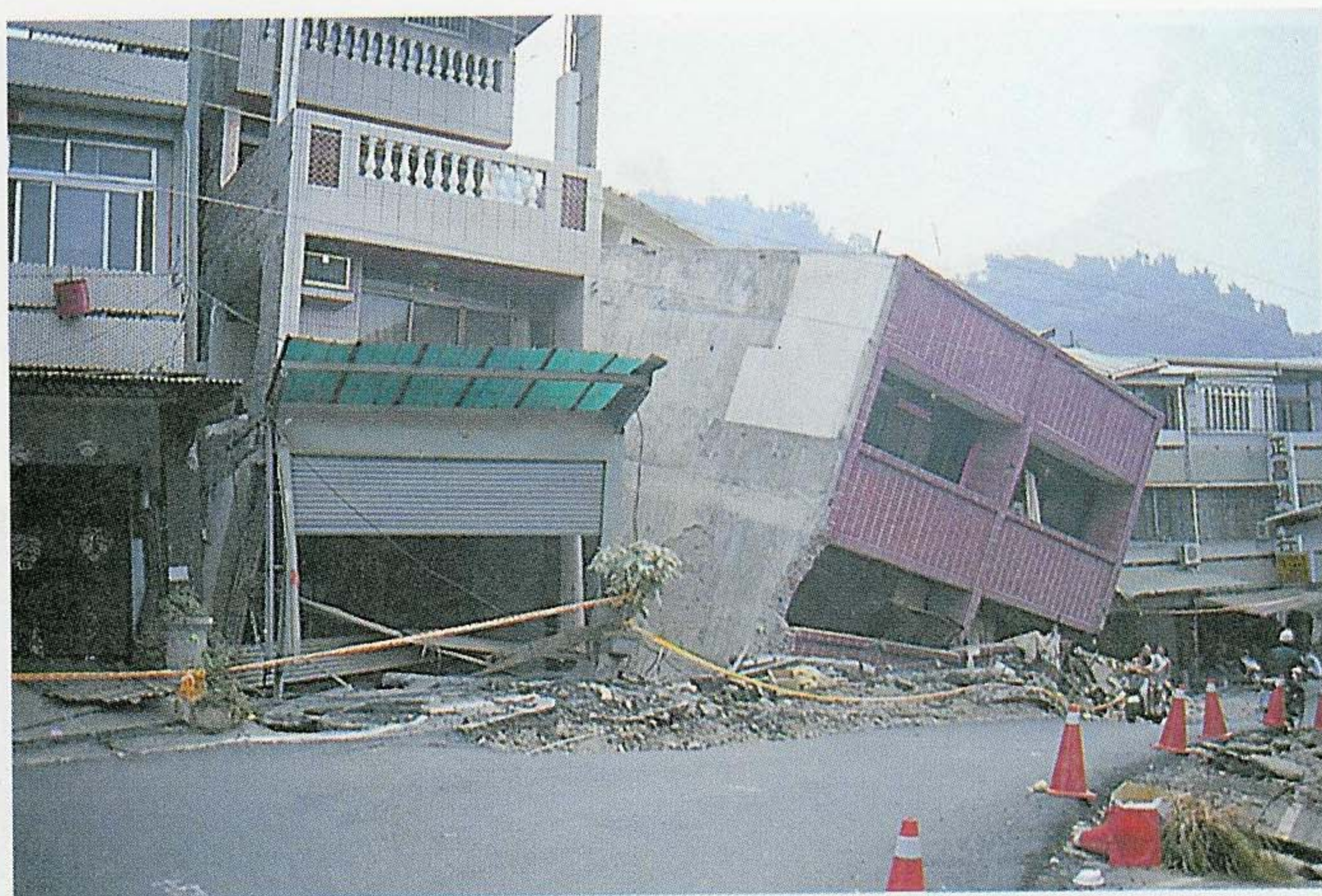
► 圖22 部子坑：地震斷層通過紅色房屋的右側並將房屋與道路抬起約3公尺，造成一樓完全被壓毀並向一側傾倒，兩側房屋則沒有倒塌只受部份的損壞。
