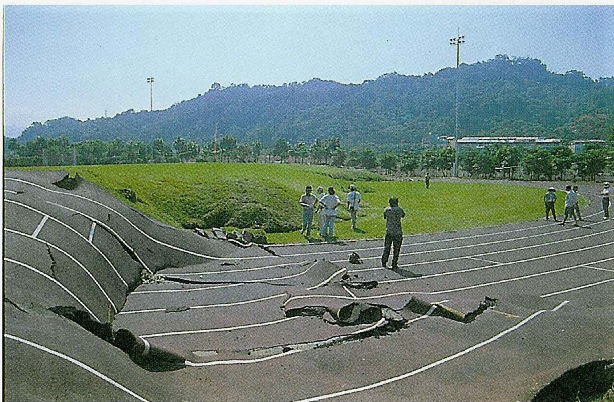
◀ 圖13 霧峰光復國小：地殼隆起將操場斷成兩個階面，階面相交處約呈一直線，這就是斷層露出地表的斷層線位置。
