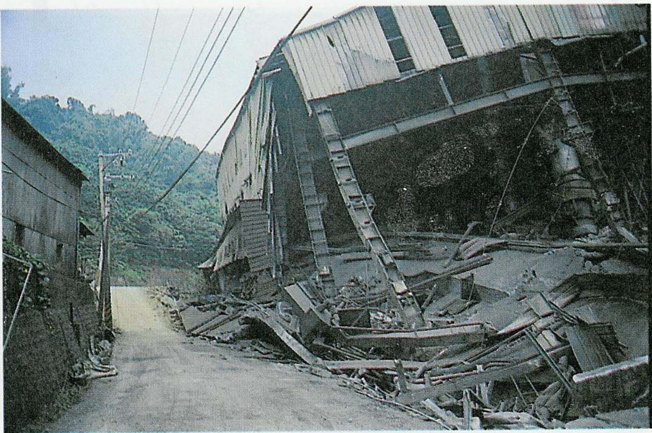
◀ 圖21 太平(七星仔)：一座鋼骨結構的鐵工廠橫跨在斷層之上，地震斷層將廠房的後側抬升約3公尺，使得廠房向一側傾倒。斷層向左截過道路(黃色路面)也將路面抬起。
